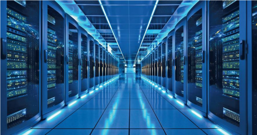
Figura 1.21. Cuarto de telecomunicaciones en un entorno IT. Estos cuartos recogen en armarios rack el cableado y la electrónica de la red de una organización.
